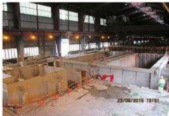
TRIMET - Four à Anode
