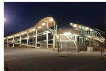
Cluses - Passerelle piéton
