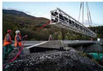
A43 - Passage Ouvrage
