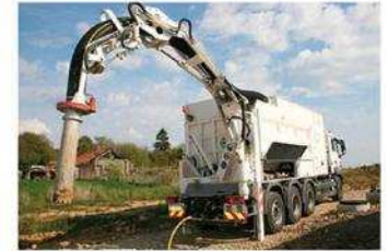
Travaux à l'Aspiratrice
